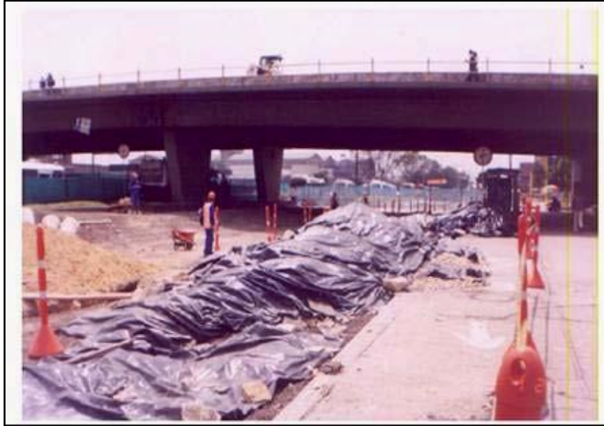
Figura 8.7 Cubrimiento de escombros con plástico
